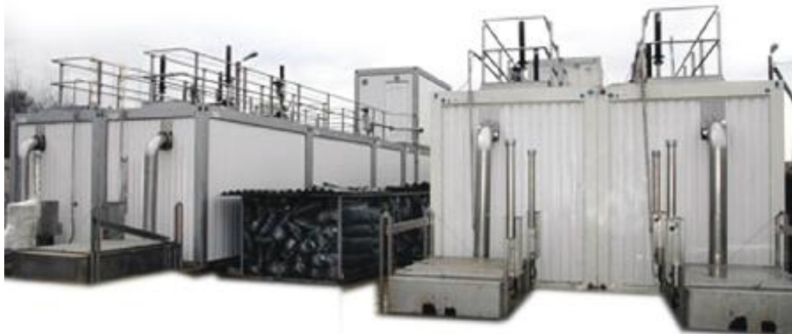
Рисунок 7 – Компактные очистные сооружения глубокой биологической очистки сточных вод блочно-модульного типа «БИОКОМС»
